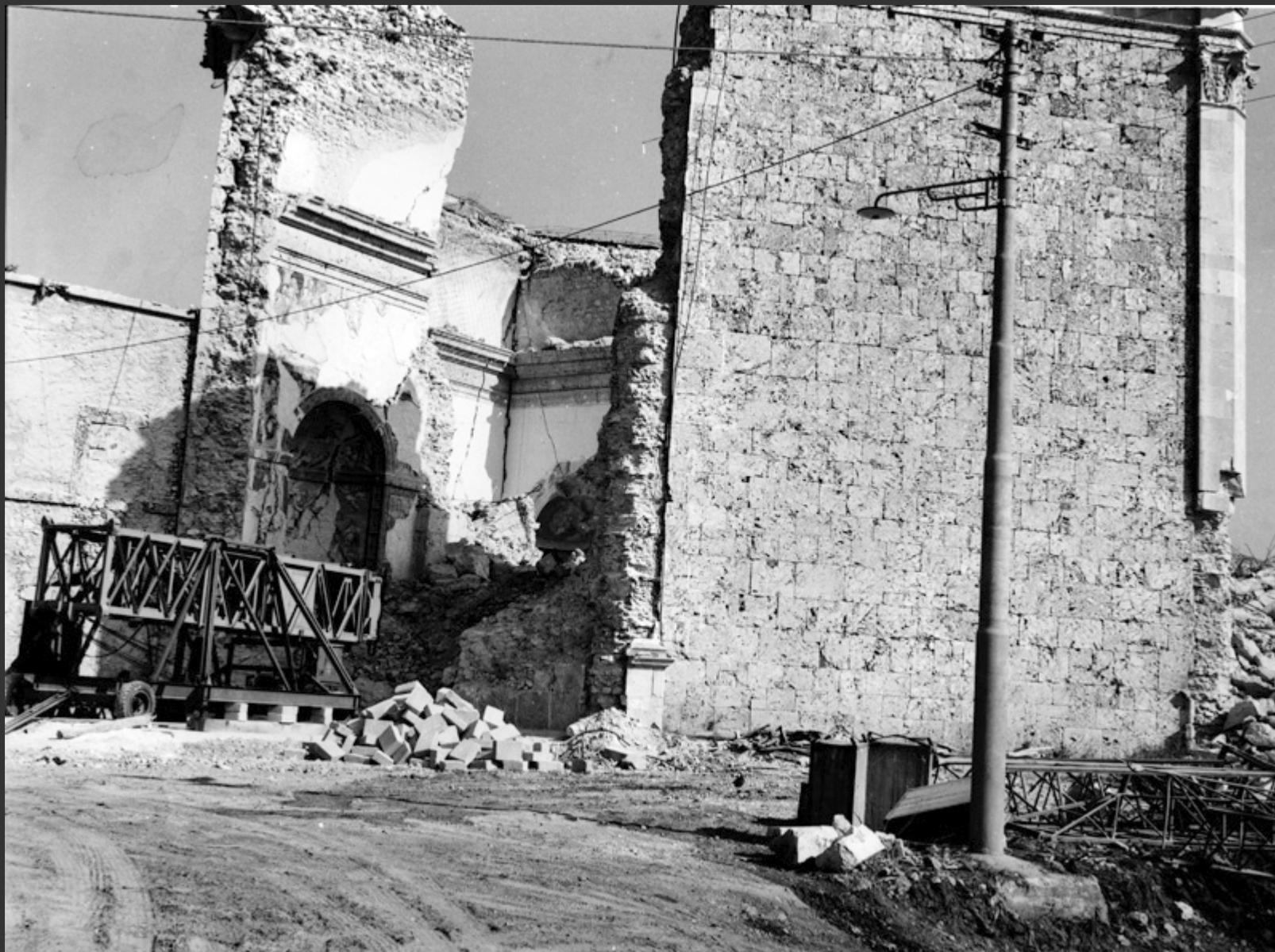
Scorci durante i lavori di rimozione delle macerie e fissaggio degli affreschi. Questa operazione è stata effettuata con l'aiuto di una gabbia metallica, costruita ad ok, appesa alla gru che provvedeva agli spostamenti fino ad una diecina di metri di altezza, e pronti ad abbassare a terra la gabbia con i restauratori quando si sollevavano folate di vento, lassù molto forti. La velatura di garza veniva fissata con resina acrilica (Paraloid B77 al 15-20%).
