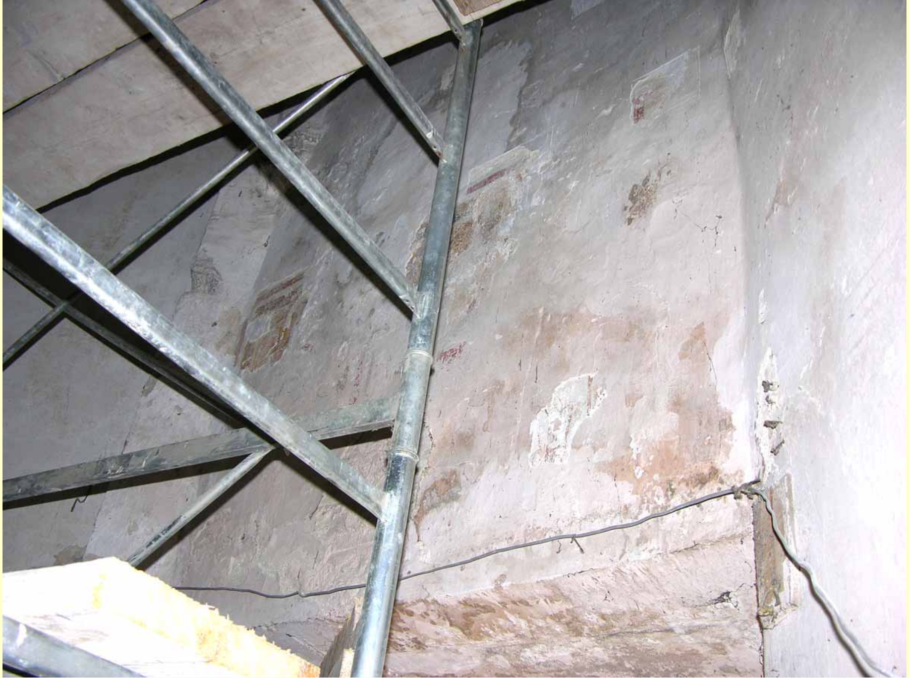
Saggi nelle pareti dell'abside della chiesa antica.
